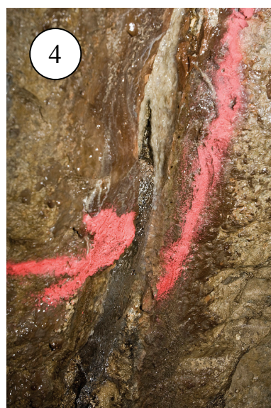
Figura 4-3 - Principali perdite riscontrate nel cunicolo di drenaggio.
